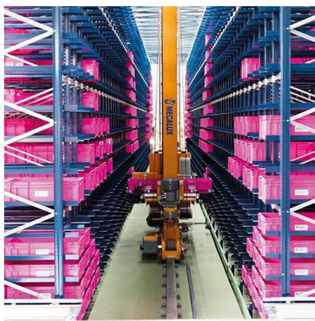
Figura 11. OSR automático en un almacén de recambios
