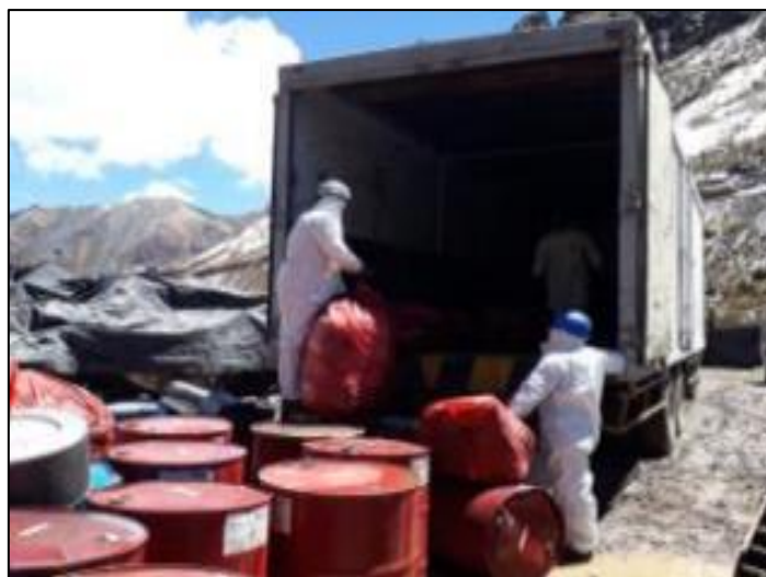
Figura 10: Personal de la EO-RS HF hermanos realizando la evacuación de residuos peligrosos
